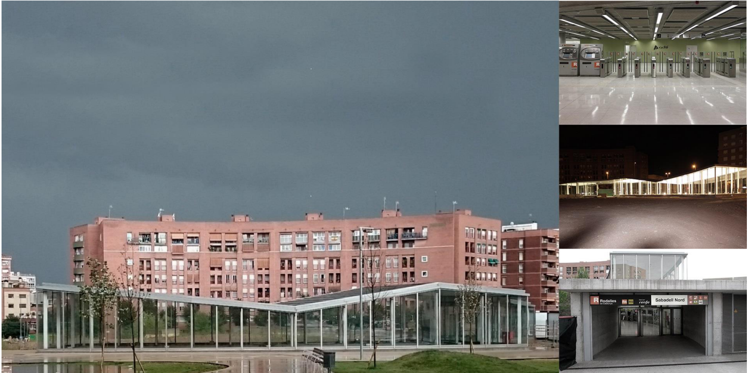
nuevo vestíbulo y nuevos accesos a los andenes
